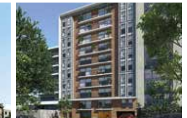
Casa Paraud Miraflores EN CONSTRUCCIÓN
