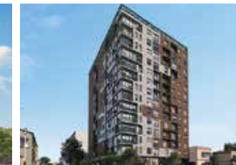
Villa Velarde Lince EN CONSTRUCCIÓN
