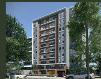
Casa Paraud Miraflores EN CONSTRUCCIÓN
